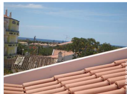
vista a partir do terraço sobre telhado
