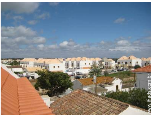
vista a partir do terraço sobre telhado
