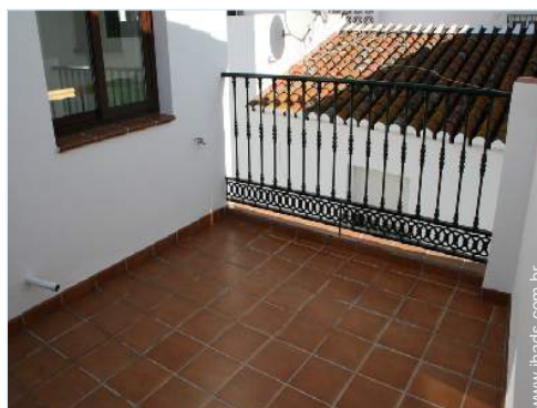
vista a partir do terraço sobre telhado
