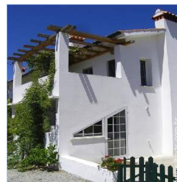
terraço no telhado
