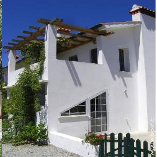
terraço no telhado
