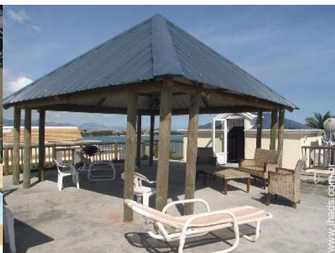
terraço no telhado
