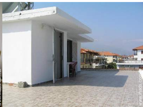
vista a partir do terraço sobre telhado
