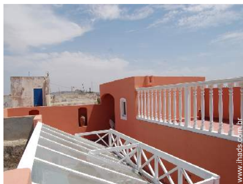
vista a partir do terraço sobre telhado
