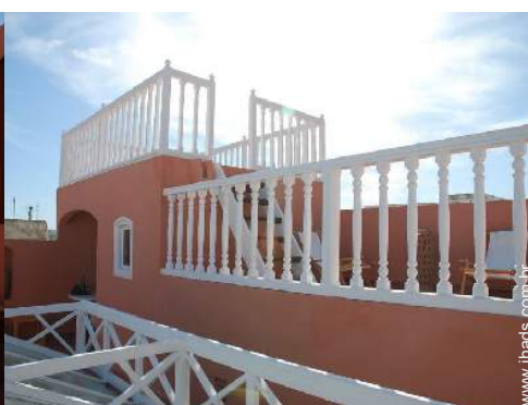
vista a partir do terraço sobre telhado
