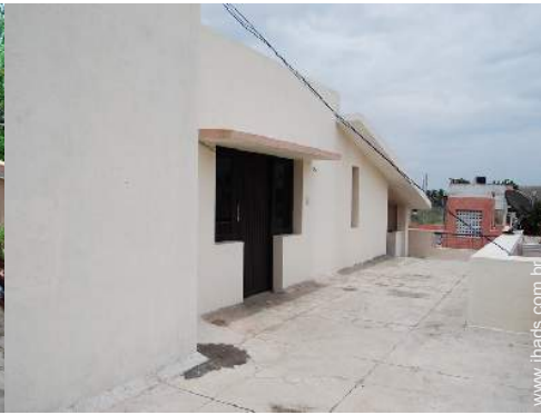
terraço no telhado
