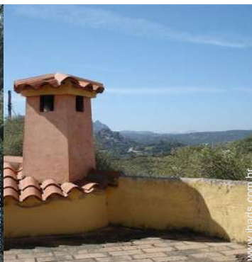
vista a partir do terraço sobre telhado
