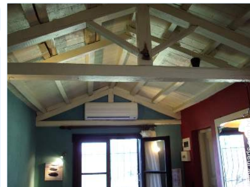
ar condicionado (totalmente)
