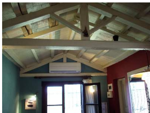
ar condicionado (totalmente)
