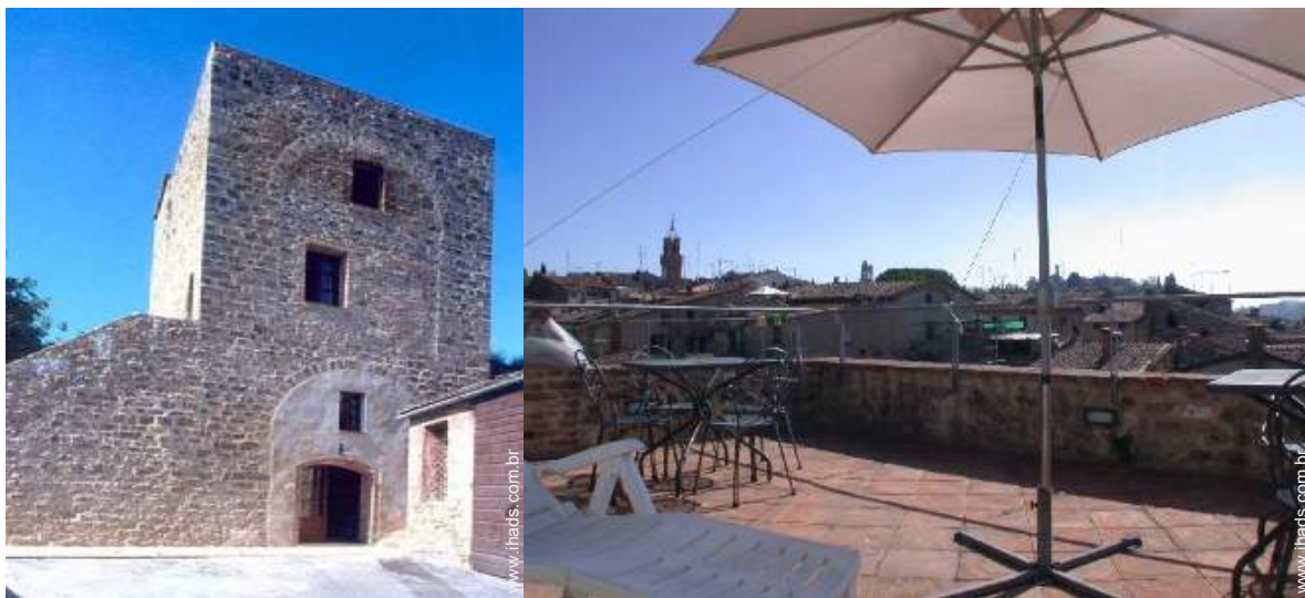
vista a partir do terraço sobre telhado
