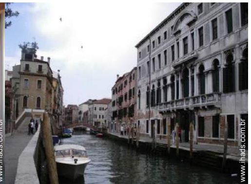
Casa de canal encantadora
